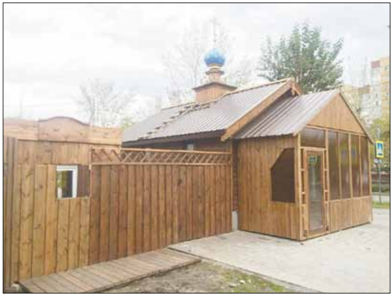
Временный храм-часовня на месте строительства Покровского храма г. Тюмени
